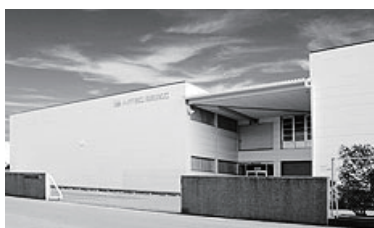
自動化システム事業部外観
