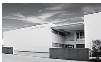
自動化システム事業部外観
